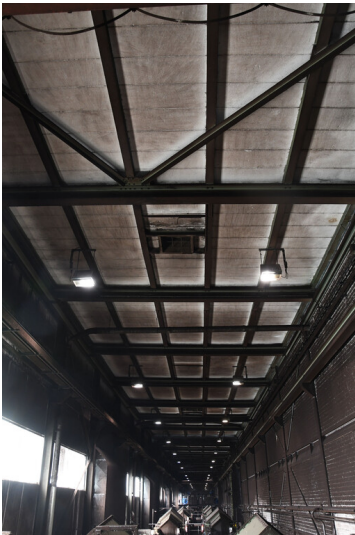
Kraftwerk Neurath: Zwischenbau Blöcke A/B, Details der Konstruktion, Innenansicht; Foto: 14.09.2023 Fotograf/Urheber: Dr. Norbert Gilson
