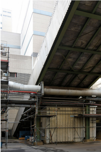
Kraftwerk Neurath: Bekohlungsweg Brecherei - Blöcke D/E, Ausgang der Schrägbandbrücke aus dem Brechereigebäude, Ansicht von Westen; Foto: 12.09.2023 Fotograf/Urheber: Dr. Norbert Gilson
