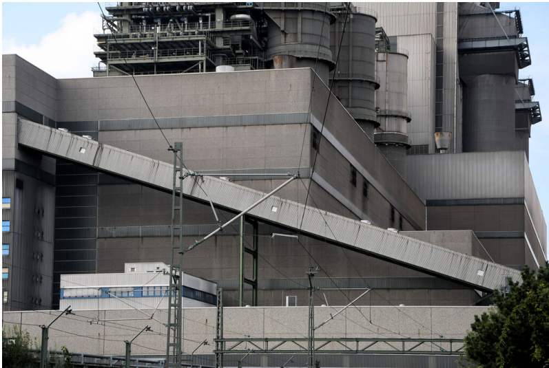
Kraftwerk Neurath: Bekohlungsweg vom Brechereigebäude zum Bekohlungs-vorbau als Schrägbandbrücke, Ansicht von Osten; Foto: 12.09.2023 Fotograf/Urheber: Dr. Norbert Gilson
