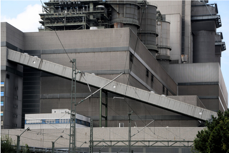
Kraftwerk Neurath: Bekohlungsweg vom Brechereigebäude zum Bekohl.vorbau als Schrägbandbrücke, Ansicht von Osten; Foto: 12.09.2023 Fotograf/Urheber: Dr. Norbert Gilson
