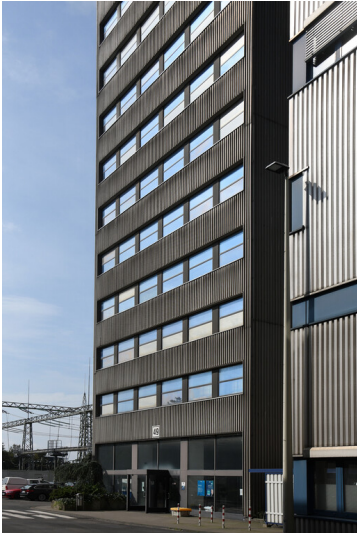
Kraftwerk Neurath: Bekohlungsverbau, Eingang und Bürogeschosse im unteren Gebäudebereich, Ansicht von Nordosten; Foto: 12.09.2023 Fotograf/Urheber: Dr. Norbert Gilson
