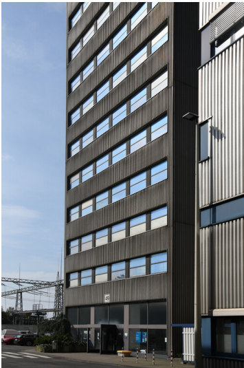
Kraftwerk Neurath: Bekohlungsverbau, Eingang und Bürogeschosse im unteren Gebäudebereich, Ansicht von Nordosten; Foto: 12.09.2023 Fotograf/Urheber: Dr. Norbert Gilson
