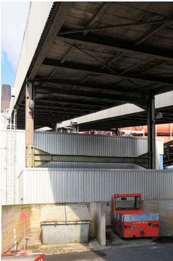
Kraftwerk Neurath: Schrägbandbrücke zwischen Eisenausscheidung und Brecherei, Brückenkonstruktion und Einfeldträger, Ansicht von Osten; Foto: 12.09.2023 Fotograf/Urheber: Dr. Norbert Gilson
