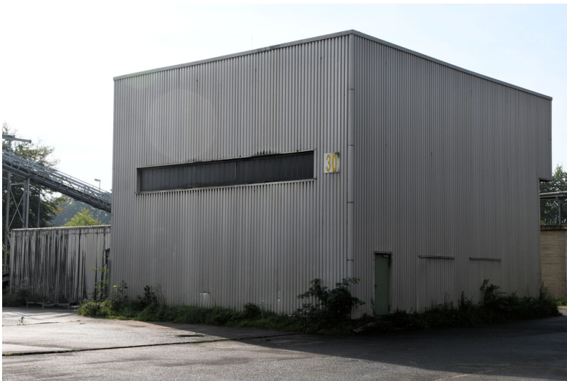
Kraftwerk Neurath: Grabenbunkereckturm, Ansicht von Nordwesten; Foto: 12.09.2023 Fotograf/Urheber: Dr. Norbert Gilson
