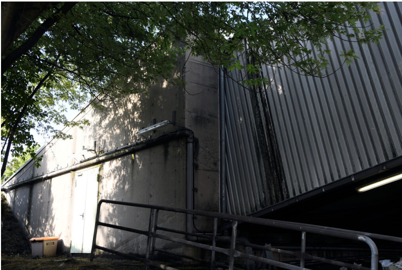
Kraftwerk Neurath: Übergabestation, Ausgang der Schrägbandbrücke zur Eisenausscheidung, Ansicht von Nordosten; Foto: 12.09.2023 Fotograf/Urheber: Dr. Norbert Gilson
