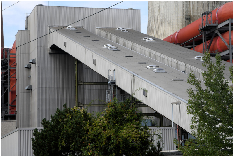
Kraftwerk Neurath: Brecherei, Zuführung der Bandbrücken von der Eisenausscheidung, Ansicht von Südosten; Foto: 12.09.2023 Fotograf/Urheber: Dr. Norbert Gilson
