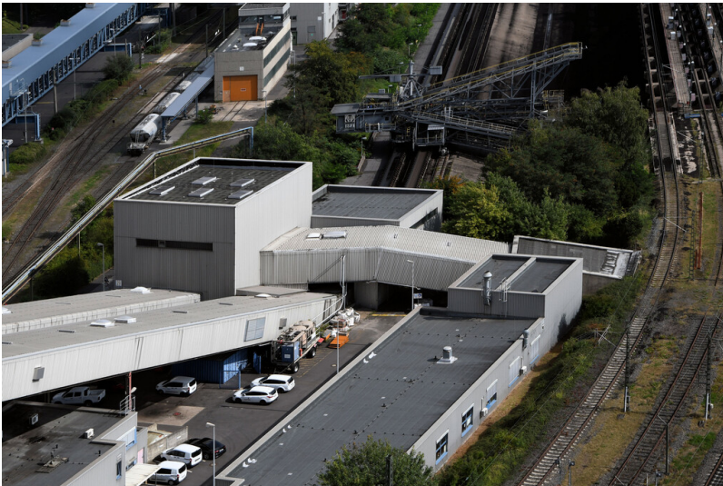
Kraftwerk Neurath: Eisenausscheidung (hohes und niedrigeres Gebäude in Bildmitte), Ansicht von Westen (von Kesselhausdach Block A); Foto: 14.09.2023 Fotograf/Urheber: Dr. Norbert Gilson
