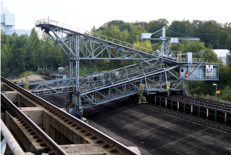
Kraftwerk Neurath: Bunkerbagger 3, Ansicht von Nordwesten; Foto: 12.09.2023 Fotograf/Urheber: Dr. Norbert Gilson
