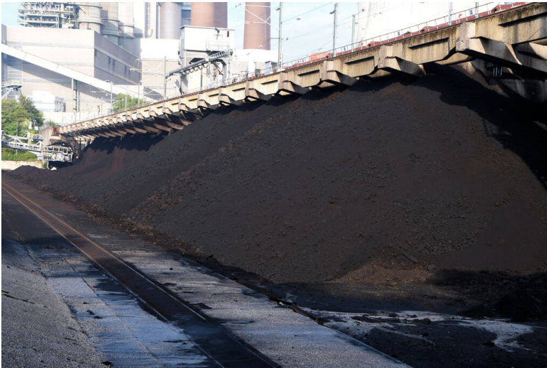
Kraftwerk Neurath: Grabenbunker 2, Kohlehalde, Ansicht von Südosten; Foto: 12.09.2023 Fotograf/Urheber: Dr. Norbert Gilson
