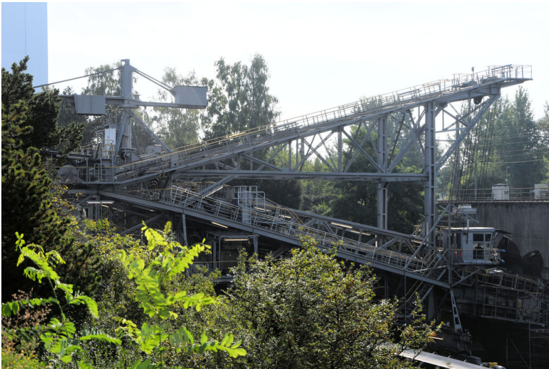
Kraftwerk Neurath: Bunkerbagger 1, Ansicht von Nordwesten; Foto: 12.09.2023 Fotograf/Urheber: Dr. Norbert Gilson
