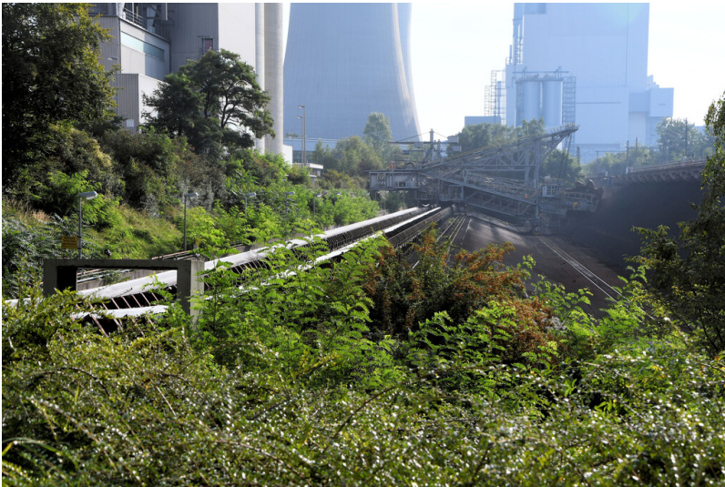
Kraftwerk Neurath: Bunkerbagger 2 im Grabenbunker 1, Ansicht von Westen; Foto: 12.09.2023 Fotograf/Urheber: Dr. Norbert Gilson
