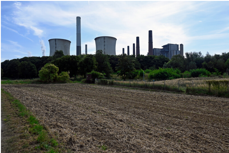
Kraftwerk Neurath Fotograf/Urheber: Karl Peter Wiemer
