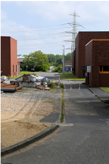
Kraftwerk Goldenberg-Werk: Verlauf der Werkstraße (11) in Richtung Kreuzung mit der Kasinostraße, Ansicht von Südwesten; Foto: 25.05.2023 Fotograf/Urheber: Dr. Norbert Gilson
