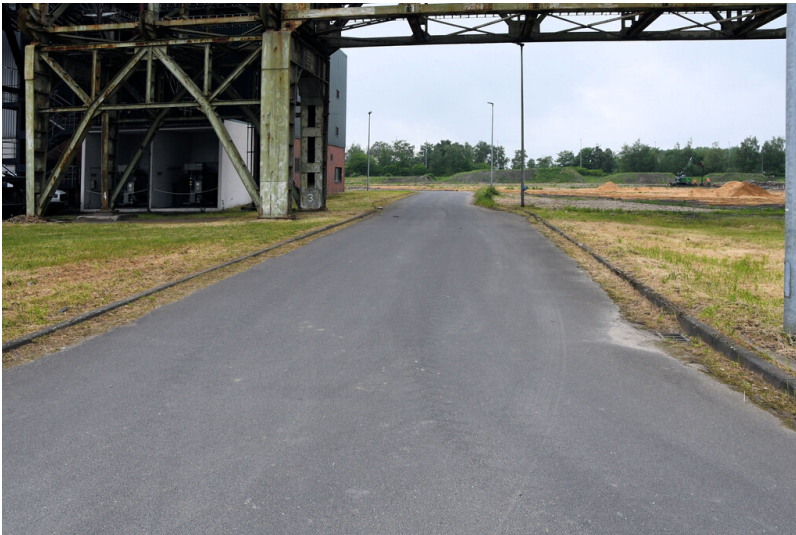
Kraftwerk Goldenberg-Werk: Abzweig von Werkstraße (9) zur Schaltanlage des PD Brechereigebäudes, Ansicht von Südosten; Foto: 23.05.2023 Fotograf/Urheber: Dr. Norbert Gilson
