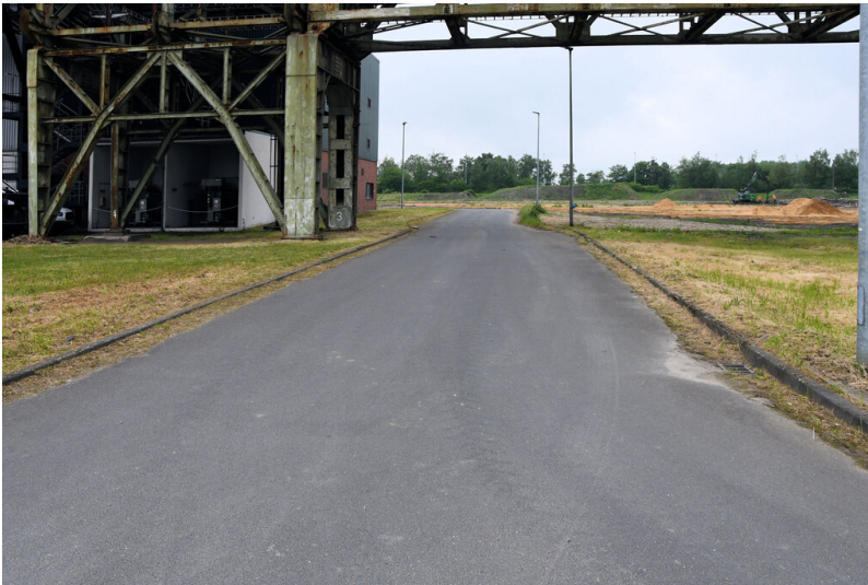
Kraftwerk Goldenberg-Werk: Abzweig von Werkstraße (9) zur Schaltanlage des PD Brechereigebäudes, Ansicht von Südosten; Foto: 23.05.2023 Fotograf/Urheber: Dr. Norbert Gilson
