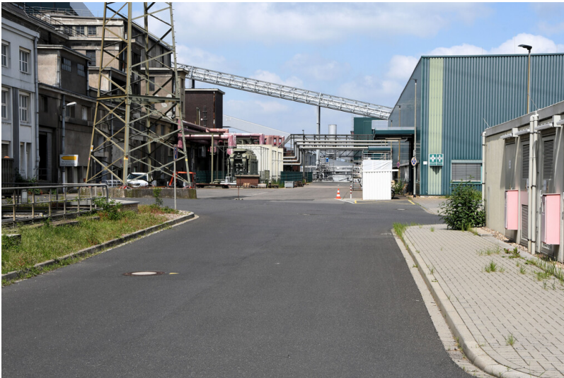
Kraftwerk Goldenberg-Werk: Werkstraße (8) vor der 25-kV-Schaltanlage, Ansicht von Südosten; Foto: 25.05.2023 Fotograf/Urheber: Dr. Norbert Gilson
