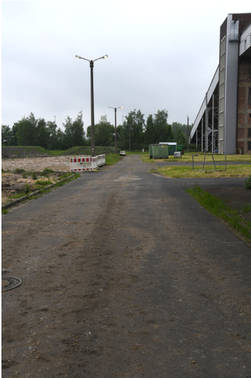
Kraftwerk Goldenberg-Werk: Werkstraße (7). Verlauf parallel zur Bekohlungsbandbrücke zwischen dem Grabenbunker Gotteshülfe und dem Bekohlungsseckturm C, Ansicht von Südosten; Foto: 23.05.2023 Fotograf/Urheber: Dr. Norbert Gilson
