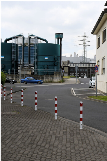
Kraftwerk Goldenberg-Werk: Werkstraße (6), Verlauf in Richtung Betriebslabor der Wasseraufbereitung, Ansicht von Nordosten; Foto: 25.05.2023 Fotograf/Urheber: Dr. Norbert Gilson
