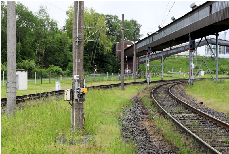
Kraftwerk Goldenberg-Werk: Abzweig des Vorbeifahrgleises (links) vom Zufahrtsgleis zum Grabenbunker Gotteshülfe (rechts), Ansicht von Nordosten; Foto: 23.05.2023 Fotograf/Urheber: Dr. Norbert Gilson
