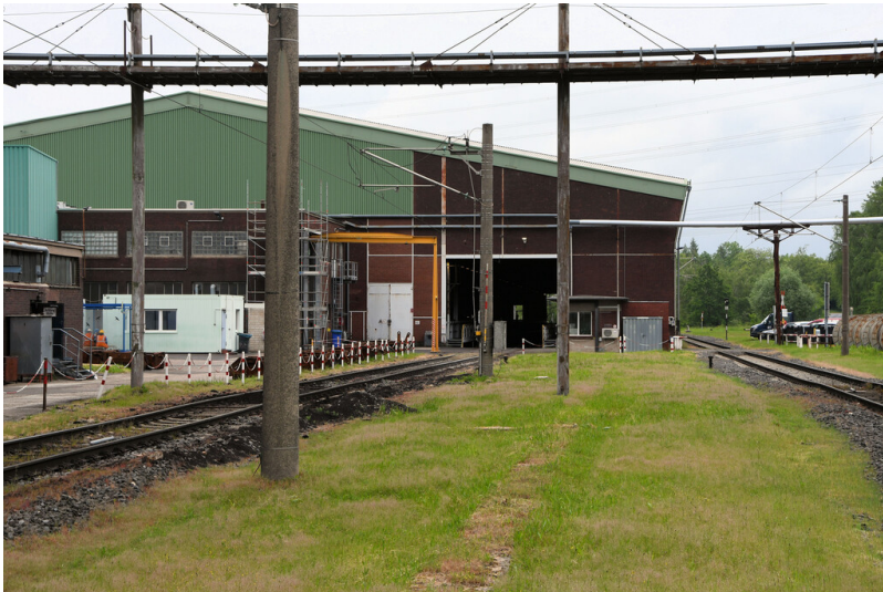
Kraftwerk Goldenberg-Werk: Gleisanlage am Grabenbunker Gotteshölfe mit Einfahrgleis (links) und Vorbeifahrgleis (rechts), Ansicht von Südwesten; Foto: 23.05.2023 Fotograf/Urheber: Dr. Norbert Gilson
