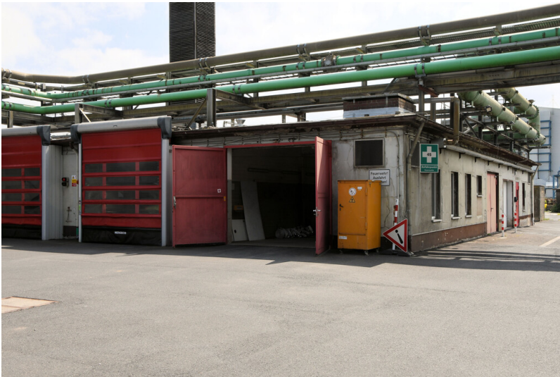
Kraftwerk Goldenberg-Werk: Feuerwehr-Gebäude, Ansicht von Westen; Foto: 25.05.2023 Fotograf/Urheber: Dr. Norbert Gilson
