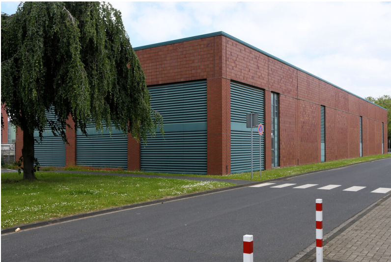
Kraftwerk Goldenberg-Werk: Lagerwirtschaftsgebäude PHI - Lager 4, Ansicht von Süden; Foto: 25.05.2023 Fotograf/Urheber: Dr. Norbert Gilson
