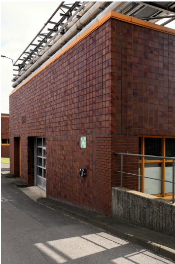
Kraftwerk Goldenberg-Werk: Bauhof, Ansicht von Südwesten; Foto: 25.05.2023 Fotograf/Urheber: Dr. Norbert Gilson
