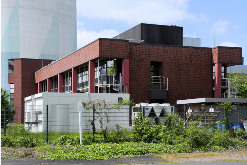
Kraftwerk Goldenberg-Werk: Ehemaliges Hauptlabor, Ansicht von Norosten; Foto: 25.05.2023 Fotograf/Urheber: Dr. Norbert Gilson
