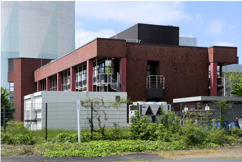
Kraftwerk Goldenberg-Werk: Ehemaliges Hauptlabor, Ansicht von Norosten; Foto: 25.05.2023 Fotograf/Urheber: Dr. Norbert Gilson
