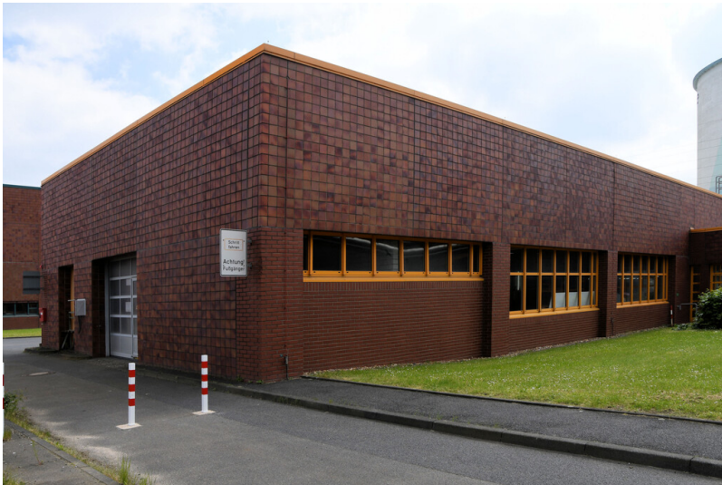
Kraftwerk Goldenberg-Werk: Elektro-Werkstatt, Ansicht von Westen; Foto: 25.05.2023 Fotograf/Urheber: Dr. Norbert Gilson
