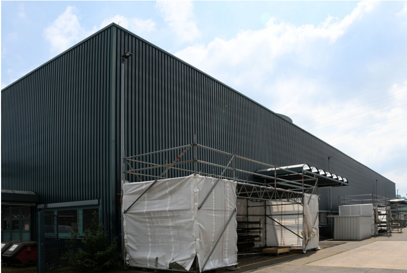
Kraftwerk Goldenberg-Werk: Maschinen-Werkstatt, Ansicht von Nordwesten; Foto: 25.05.2023 Fotograf/Urheber: Dr. Norbert Gilson
