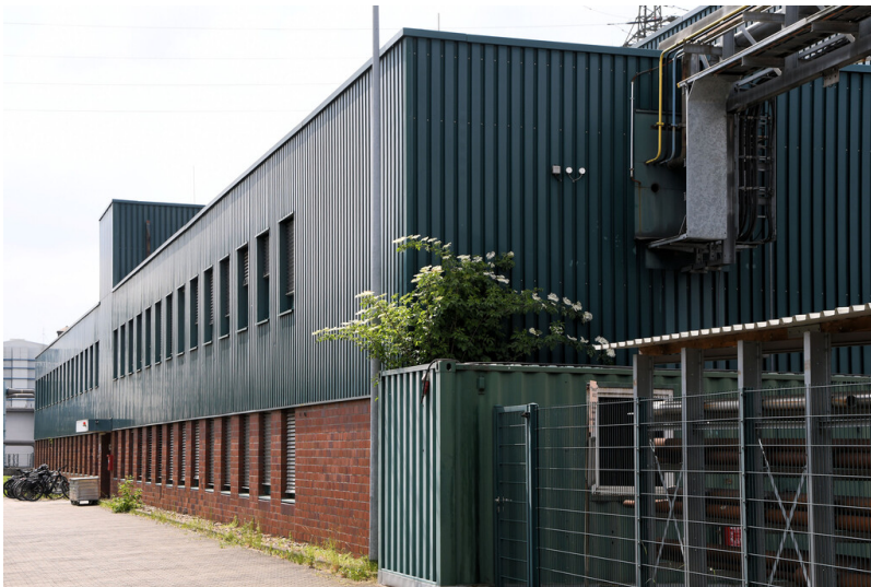
Kraftwerk Goldenberg-Werk: Verwaltung, Ansicht von Nordwesten; Foto: 25.05.2023 Fotograf/Urheber: Dr. Norbert Gilson
