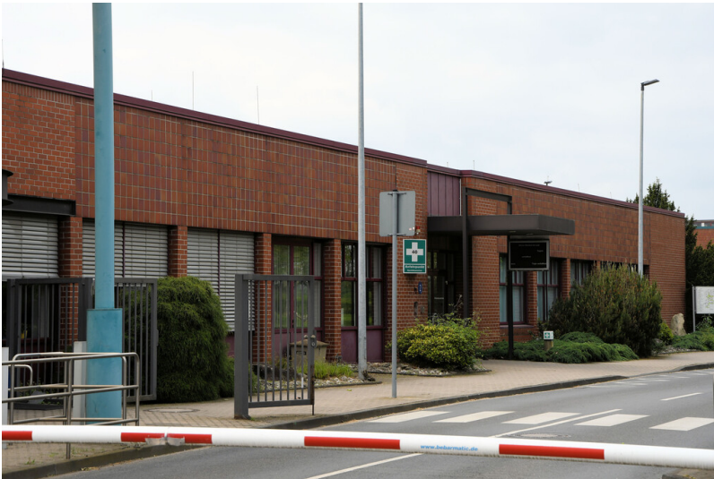
Kraftwerk Goldenberg-Werk: Gebäude der ehemaligen Werksmedizin, Ansicht von Osten; Foto: 23.05.2023 Fotograf/Urheber: Dr. Norbert Gilson
