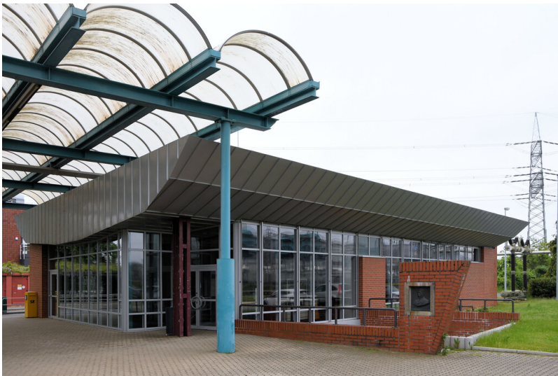
Kraftwerk Goldenberg-Werk: Info-Center, Ansicht von Westen; Foto: 23.05.2023 Fotograf/Urheber: Dr. Norbert Gilson
