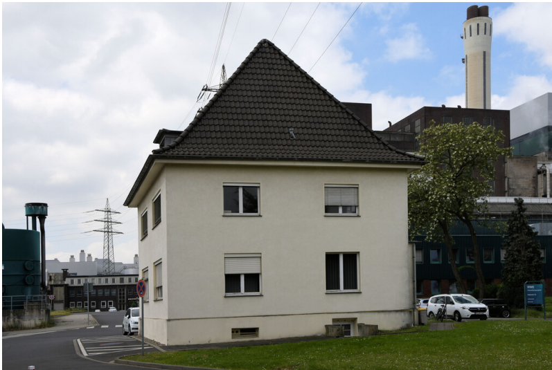
Kraftwerk Goldenberg-Werk: ehemaliges Angestellten-Wohnhaus, Ansicht von Nordosten; Foto: 25.05.2023 Fotograf/Urheber: Dr. Norbert Gilson
