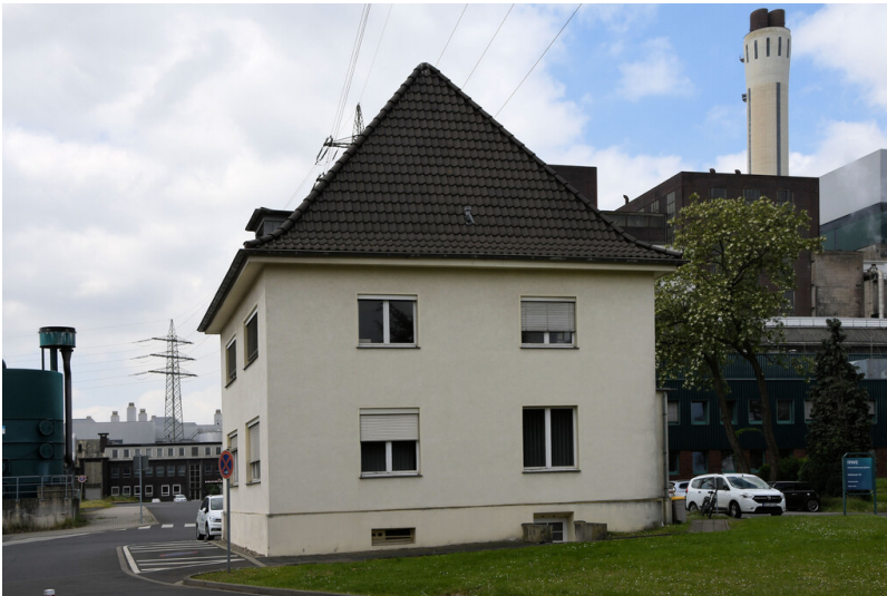
Kraftwerk Goldenberg-Werk: ehemaliges Angestellten-Wohnhaus, Ansicht von Nordosten; Foto: 25.05.2023 Fotograf/Urheber: Dr. Norbert Gilson
