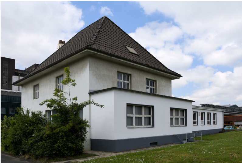
Kraftwerk Goldenberg-Werk: Haus 25 (ehemaliges Betriebsleiter-Wohnhaus) mit Anbau, Ansicht von Osten; Foto: 25.05.2023 Fotograf/Urheber: Dr. Norbert Gilson
