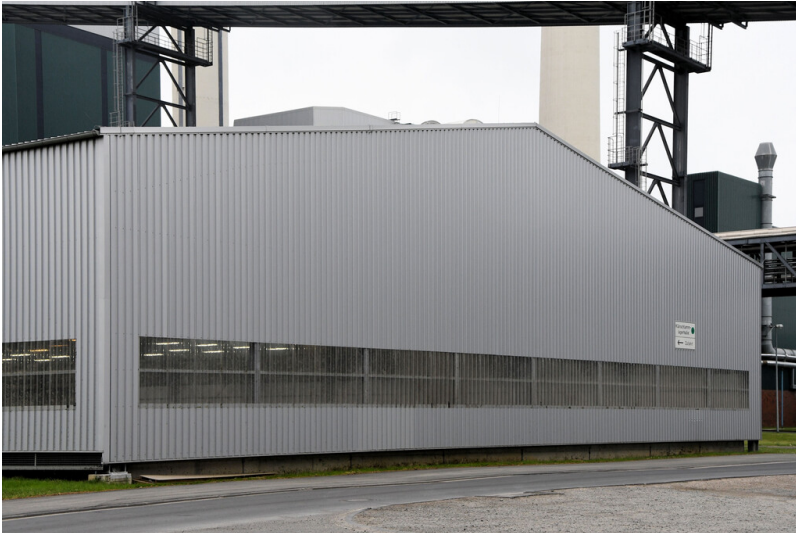
Kraftwerk Goldenberg-Werk: Klärschlamm-Lagerhalle, Ansicht von Nordwesten; Foto: 23.05.2023 Fotograf/Urheber: Dr. Norbert Gilson
