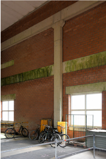
Kraftwerk Goldenberg-Werk: Abwasserhebeanlage, Innenansicht; Foto: 25.05.2023 Fotograf/Urheber: Dr. Norbert Gilson
