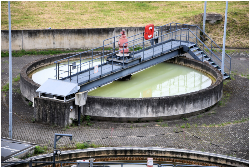
Kraftwerk Goldenberg-Werk: Eindicker, Ansicht von Südosten (vom Dach des PD Bekohlungssektors); Foto: 23.05.2023 Fotograf/Urheber: Dr. Norbert Gilson
