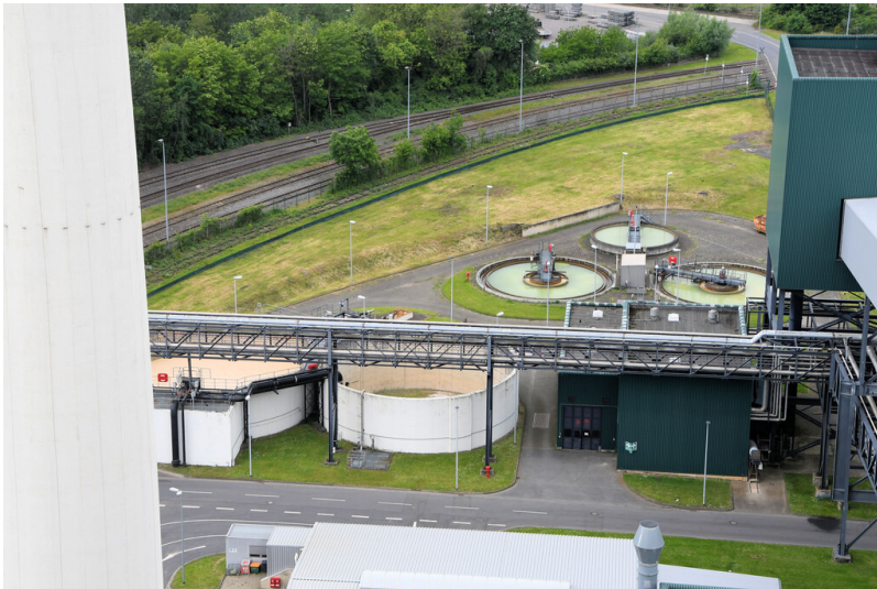
Kraftwerk Goldenberg-Werk: Fangbecken der Kläranlage (links außen), Ansicht von Südosten (vom Dach des Kesselhauses DE K); Foto: 23.05.2023 Fotograf/Urheber: Dr. Norbert Gilson
