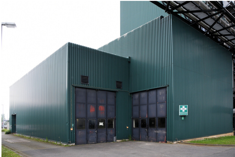
Kraftwerk Goldenberg-Werk: Betriebsgebäude der Kläranlage, Ansicht von Süden; Foto: 23.05.2023 Fotograf/Urheber: Dr. Norbert Gilson
