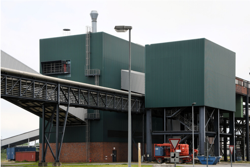
Kraftwerk Goldenberg-Werk: Führung der Fernwärme-Versorgungsleitung Hürth auf Rohrbrücke zwischen dem Übergabeturm (rechts) und dem PD Brechereigebäude, Ansicht von Süden; Foto: 23.05.2023 Fotograf/Urheber: Dr. Norbert Gilson
