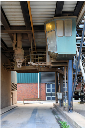
Kraftwerk Goldenberg-Werk: Aschekalkverdichterstation, Ascheverladung, Ansicht von Südwesten; Foto: 25.05.2023 Fotograf/Urheber: Dr. Norbert Gilson
