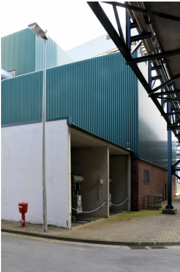
Kraftwerk Goldenberg-Werk: Schaltanlagegebäude für die Hilfsdampferzeuger L/M mit Trafoszellen, Ansicht von Süden; Foto: 25.05.2023 Fotograf/Urheber: Dr. Norbert Gilson
