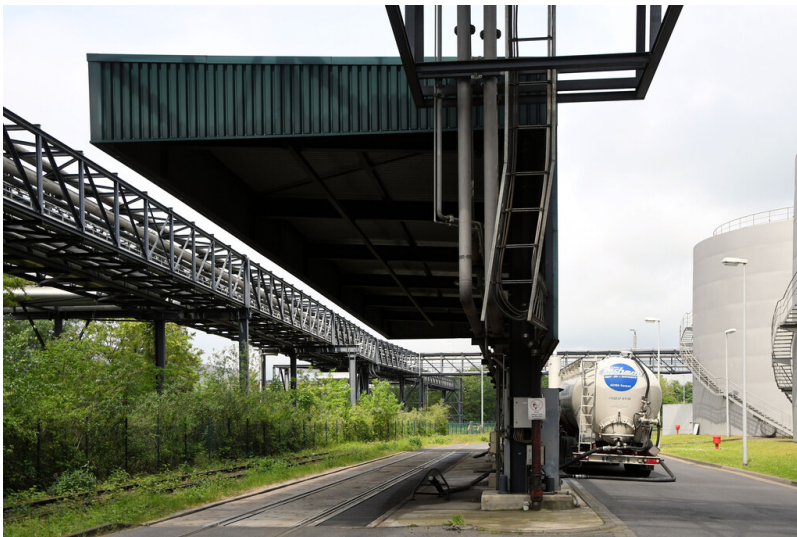
Kraftwerk Goldenberg-Werk: Öl-/Kalkübernahme, Ansicht von Südosten; Foto: 23.05.2023 Fotograf/Urheber: Dr. Norbert Gilson
