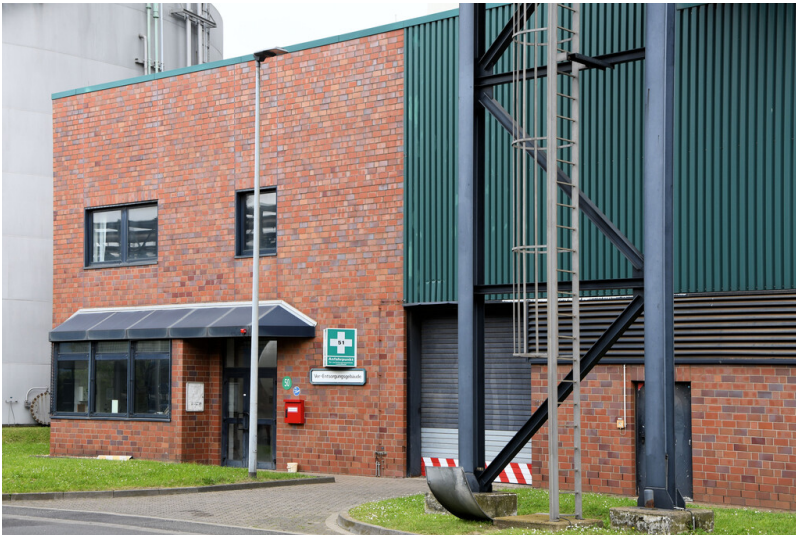
Kraftwerk Goldenberg-Werk: Ölpumpengebäude, Ansicht von Süden; Foto: 23.05.2023 Fotograf/Urheber: Dr. Norbert Gilson
