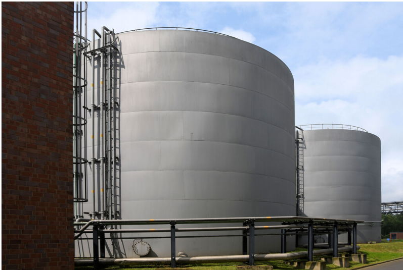
Kraftwerk Goldenberg-Werk: Leichtöltank 1 (im Hintergrund Leichtöltank 2), Ansicht von Südosten; Foto: 23.05.2023 Fotograf/Urheber: Dr. Norbert Gilson
