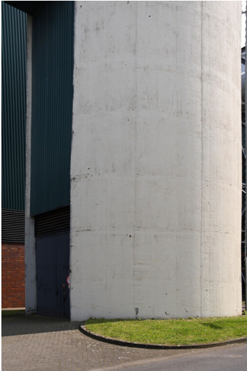
Kraftwerk Goldenberg-Werk: Fundament von Kamin L/M, Ansicht von Südwesten; Foto: 23.05.2023 Fotograf/Urheber: Dr. Norbert Gilson
