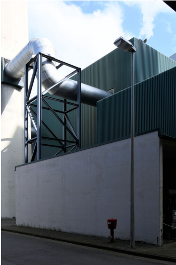
Kraftwerk Goldenberg-Werk: Hilfsdampferzeugergebäude L/M, Abgaseinleitung in den Kamin L/M, Ansicht von Süden; Foto: 25.05.2023 Fotograf/Urheber: Dr. Norbert Gilson
