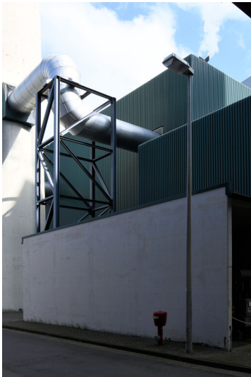
Kraftwerk Goldenberg-Werk: Hilfsdampferzeugergebäude L/M, Abgaseinleitung in den Kamin L/M, Ansicht von Süden; Foto: 25.05.2023 Fotograf/Urheber: Dr. Norbert Gilson
