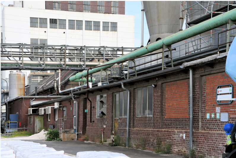
Kraftwerk Goldenberg-Werk: Gebäudetrakt der Entkarbonisierung, Ansicht von Süden; Foto: 25.05.2023 Fotograf/Urheber: Dr. Norbert Gilson
