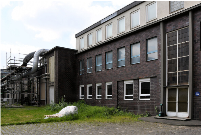
Kraftwerk Goldenberg-Werk: Betriebslabor-Gebäude, Ansicht von Norden; Foto: 25.05.2023 Fotograf/Urheber: Dr. Norbert Gilson
