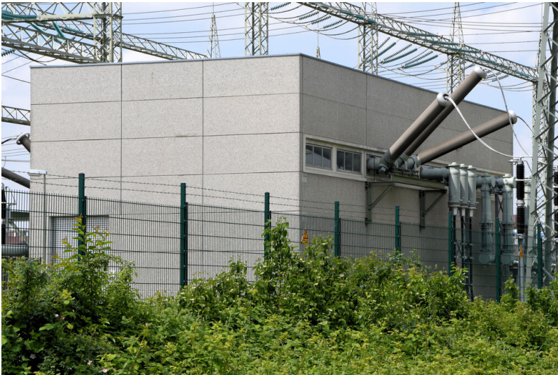
Kraftwerk Goldenberg-Werk: 380-kV-Innenraumschaltanlage, Schaltheis, Ansicht von Osten; Foto: 25.05.2023 Fotograf/Urheber: Dr. Norbert Gilson
