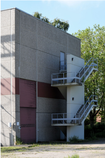
Kraftwerk Goldenberg-Werk: 110-kV-Umspannanlage Knapsack, 110-kV-Schaltheis, Zugang zum Obergeschoss, Ansicht von Norden; Foto: 25.05.2023 Fotograf/Urheber: Dr. Norbert Gilson
